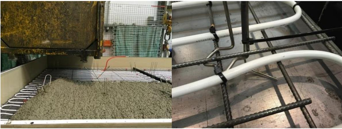
**Abb. 11: Betonieren der Vorsatzschale (links), Messfühler im Absorber (rechts).**
