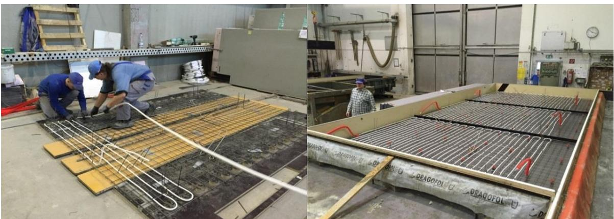
Abb. 10: Herstellen des Absorberregisters (links), eingelegte Rohrregister vor der Betonage (rechts).
