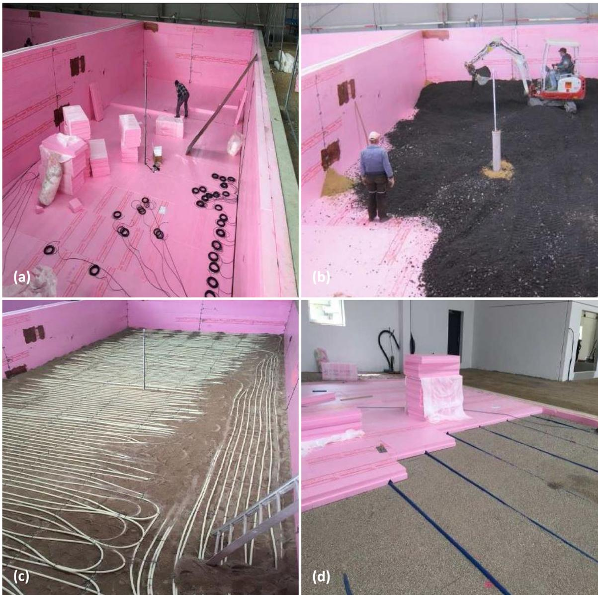
Abb. 13: Aufbau des Wärmespeichers: 20 cm starke umlaufende Perimeterdämmung, Verlegung von Temperatursensoren (a); Verfüllvorgang mit Elektroofenschlacke (Elominit) (b); Verbundrohre in doppelter Lage in einer Sandschicht (c); Wärmedämmung an der Speicheroberfläche, perforierte Kunststoffrohre zur nachträglichen Befeuchtung der Speicherfüllung (d).
